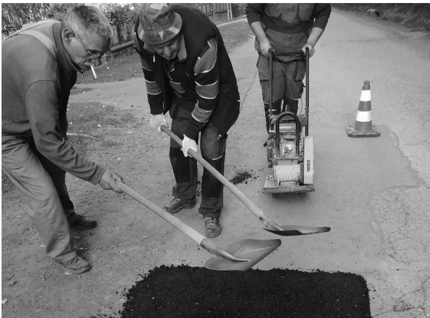
A település-üzemeltetés munkatársai új anyag felhasználásával, kísérleti jelleggel kezdték el a kátyúzási munkálatokat a Verseny utcában.
