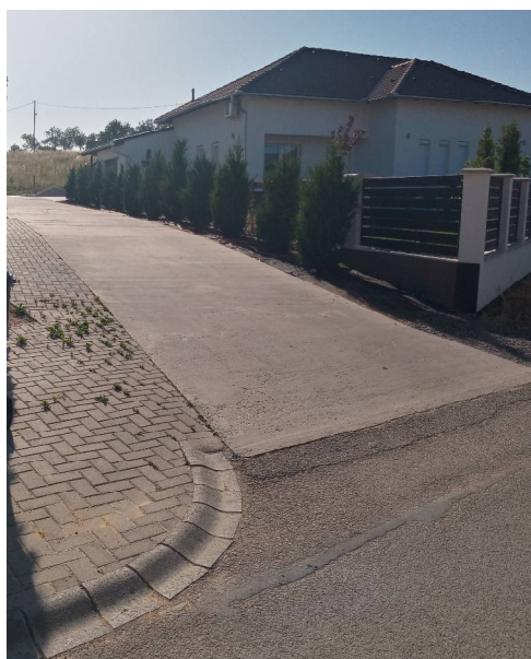
A 1208 hrsz-ú tömbfeltárási út
